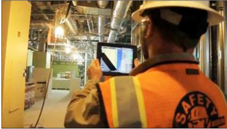
Figure 5.3 Utilisation de la RA pour confronter le modèle de conception BIM avec le tel que construit Tirée de Fetterling (2013)
